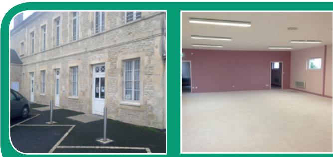
La réfection des salles
