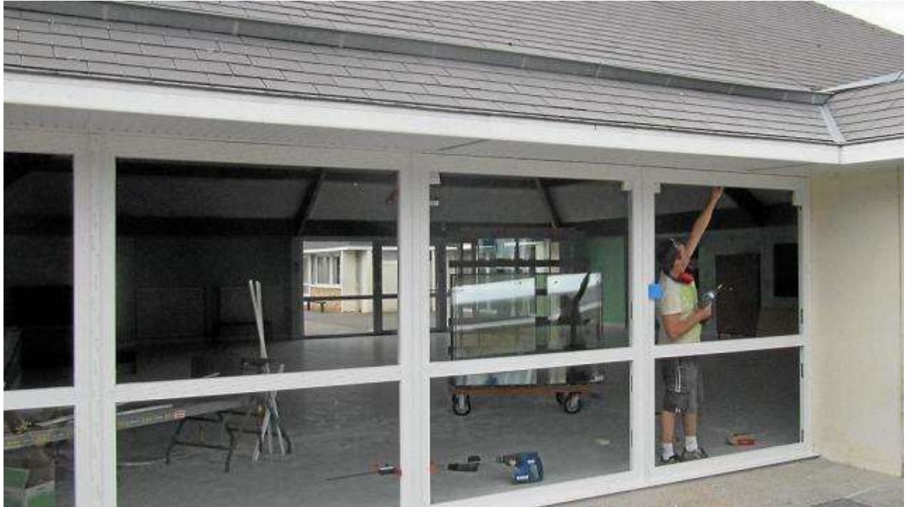
De nombreuses baies vitrées ont été remplacées.
